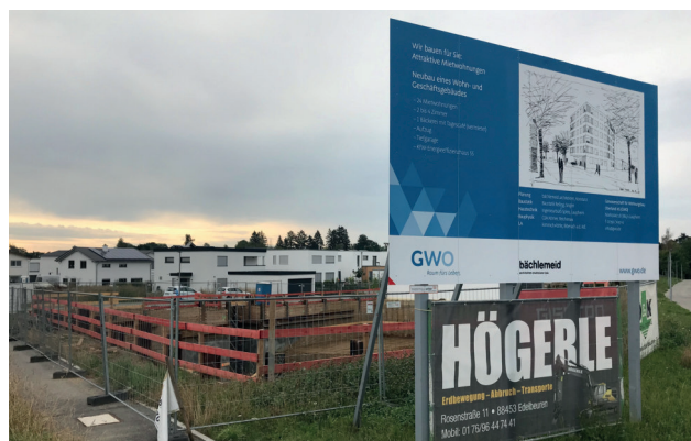
Neubau von 24 Wohneinheiten und einer Gewerbeeinheit Schweidnitzallee 2, 88400 Biberach
