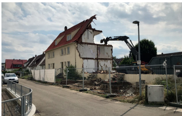
Abbruch Bestandsgebäude und Neubau von 16 Wohneinheiten, Ritter-Burkhart-Str., 88471 Laupheim
