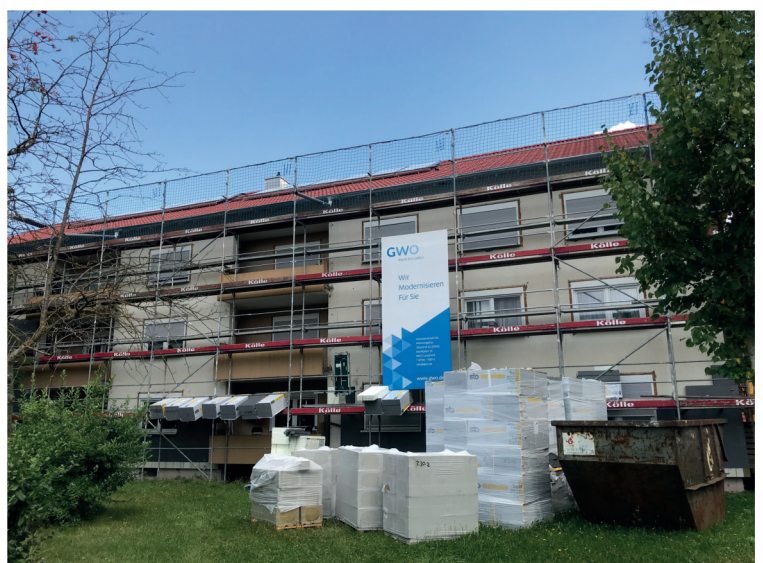
Sanierung Königsberger Str. 16/18, 88471 Laupheim
